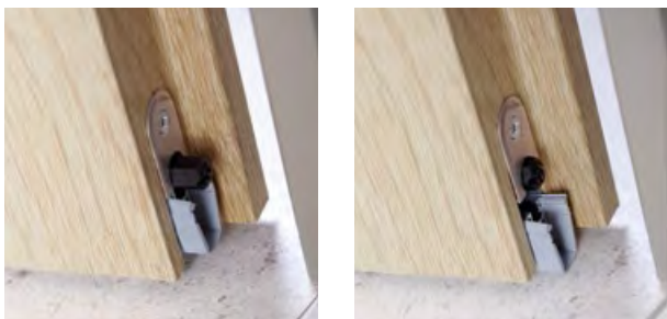
Standardausstattung bei Schallschutztüren: mechanisch absenk- bare Bodendichtung
