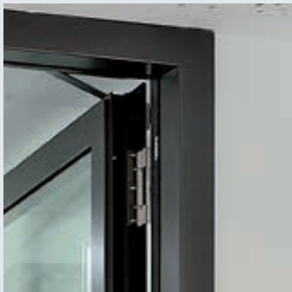
Zarge vorgerüstet für Obentürschließer
